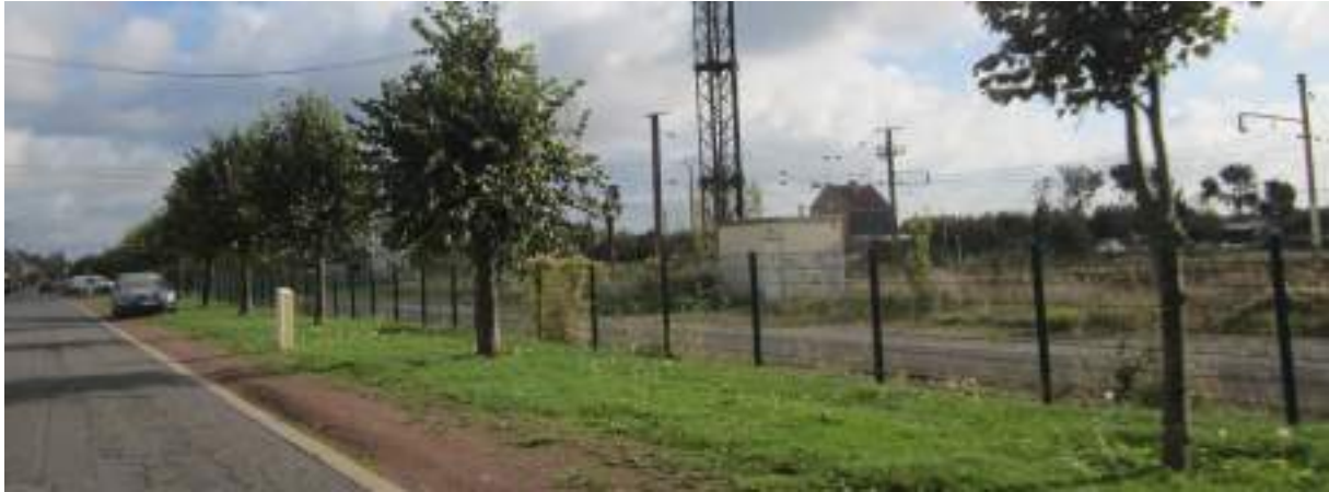
Les abords délabrés de la voie ferrée
