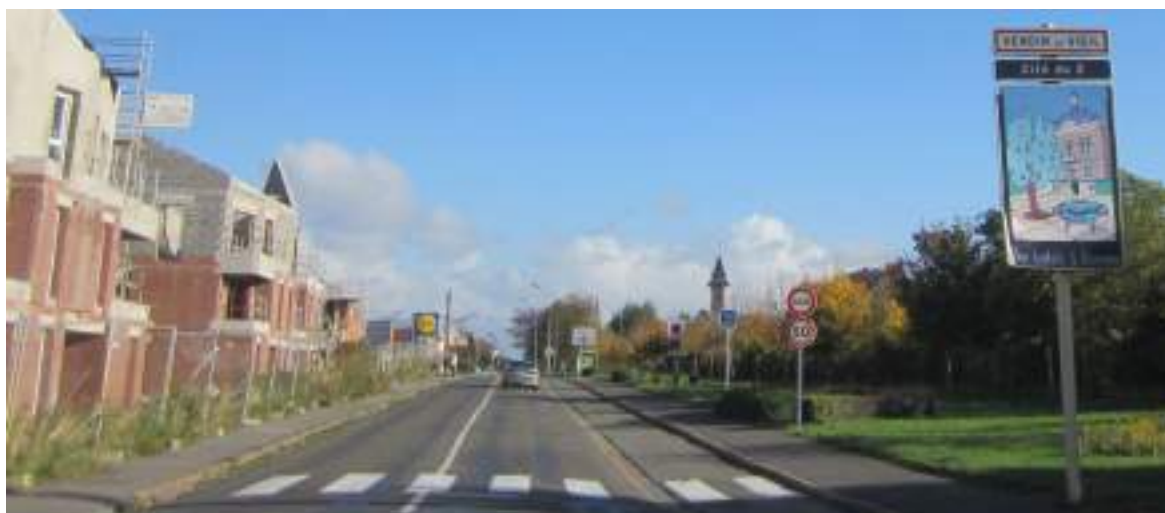
Entrée de ville Boulevard de la République – Cette entrée est en construction. Une vue vers le clocher de l'église est ouverte. Le front bâti et la bande paysagère révèle une commune urbaine à valeur bonne paysagère. La succession de panneau routier dévalorise le paysage. Il serait préférable de les regrouper.
